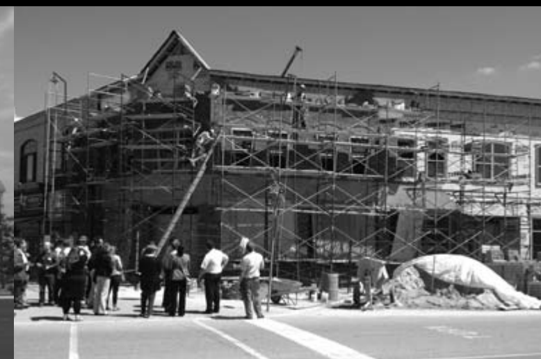
Travaux de reconstruction des édifices patrimoniaux de Goderich après le passage dévastateur de la tornade
