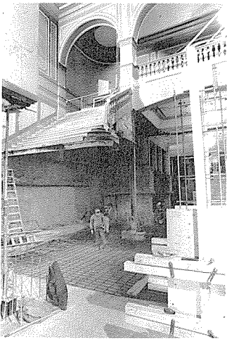
Même si la plupart des structures sont soutenues par le dessous, on connaît de nombreux exemples de structures suspendues ou en porte-à-faux. On doit avoir une compréhension complète de la structure — en ayant recours à l'avis d'un expert s'il y a lieu — avant d'entreprendre toute réfection ou modification.
