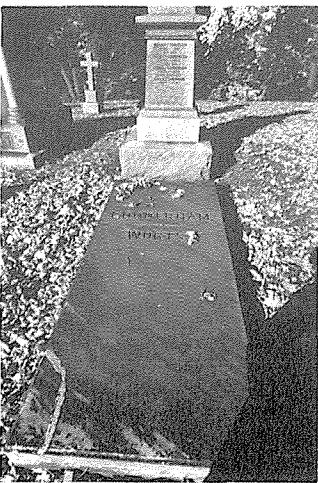
Les monuments qui reposent à même le sol sont particulièrement vulnérables aux dégâts causés par le gel ; on doit s'assurer que l'eau s'écoule rapidement avant qu'elle ne puisse pénétrer la surface.
