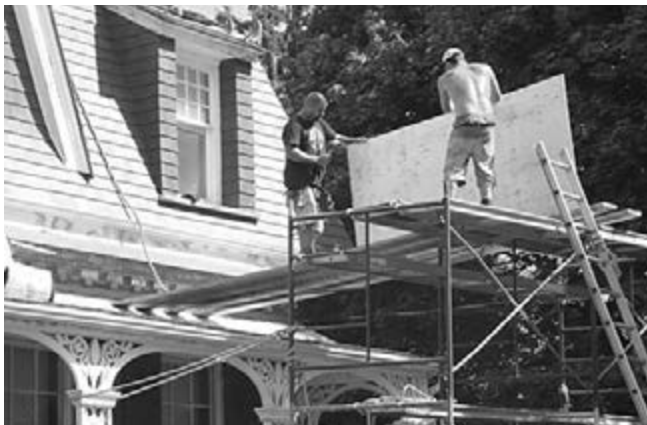
Remplacement du toit en cèdre du Domaine Ashbridge, à Toronto
