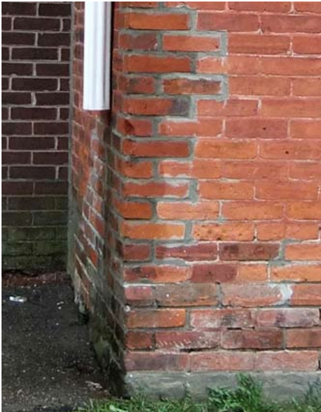
Rejointoiement incorrect
