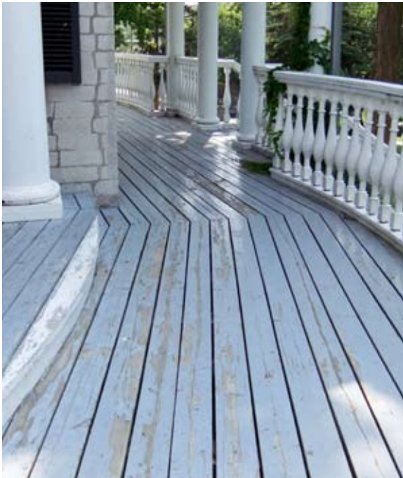
Problème de peinture sur une véranda en bois
