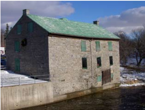
Moulin à broyer le grain de Martintown, South Glengarry
