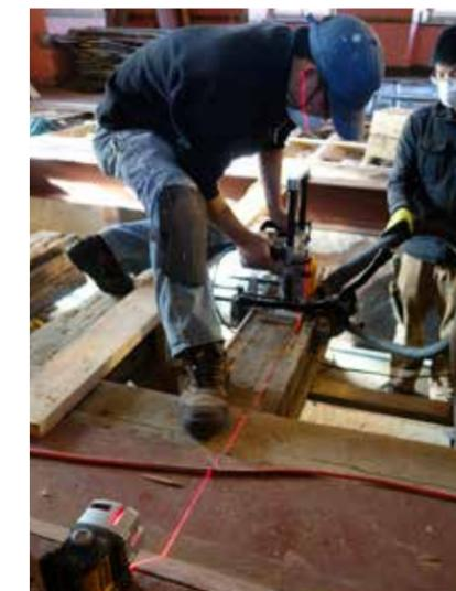
Fentes creusées dans d'anciennes poutres à l'aide d'une toupilleuse électrique à guidage de précision.
