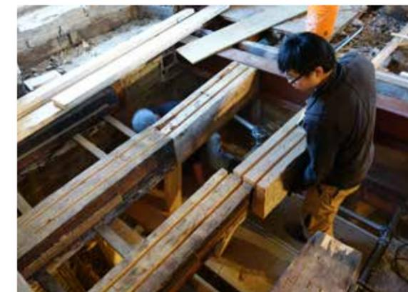
Nouvelles et anciennes poutres prêtes pour l'insertion de plaques en acier de renforcement.
