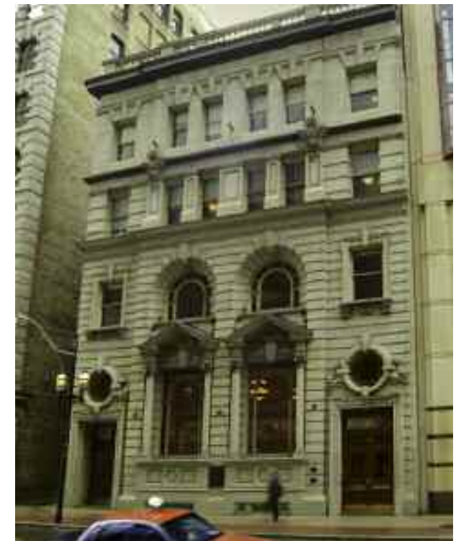
La conservation intégrée en pratique : Le Centre du patrimoine ontarien, siège social de la Fiducie, ouvert en 1987 à l'issue de la restauration des locaux et de leur réaménagement en bureaux et centre de conférences.
