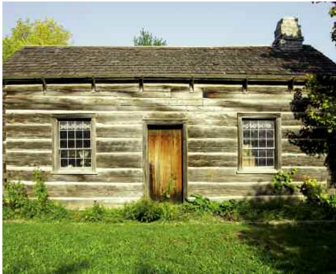
Maison Clark-McCleary, façade arrière.
