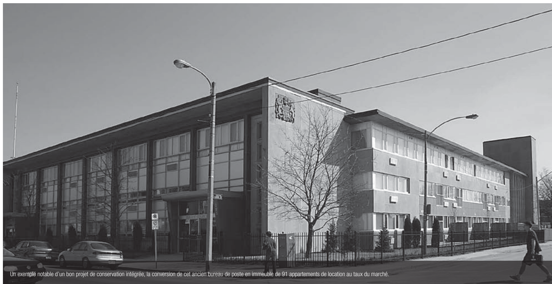
En raison du fait que le bureau de poste abritait des trieuses industrielles dont le poids nécessitait un plancher en béton armé fortement renforcé, on a pu convertir le sous-sol en aire de stationnement, un atout pour un tel projet.
