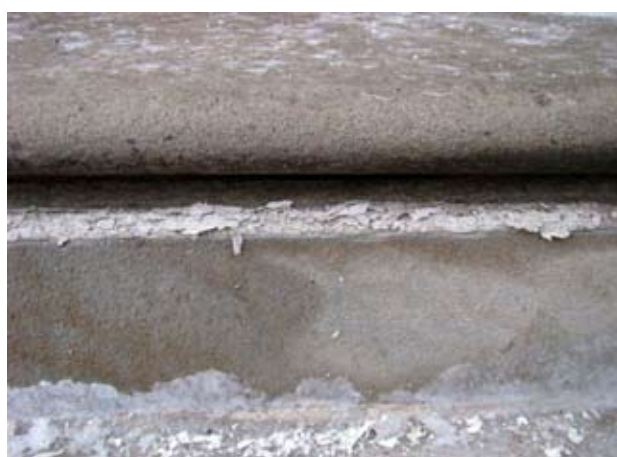
Ces marches ont été rejointoyées au début de l'hiver. Le mortier n'a pas pu atteindre la solidité structurelle prévue en raison des températures trop basses. Par conséquent, il s'est détérioré très vite, au cours de ce même hiver.
