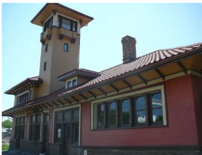
Gare d'Allandale, Barrie, avant et après restauration
