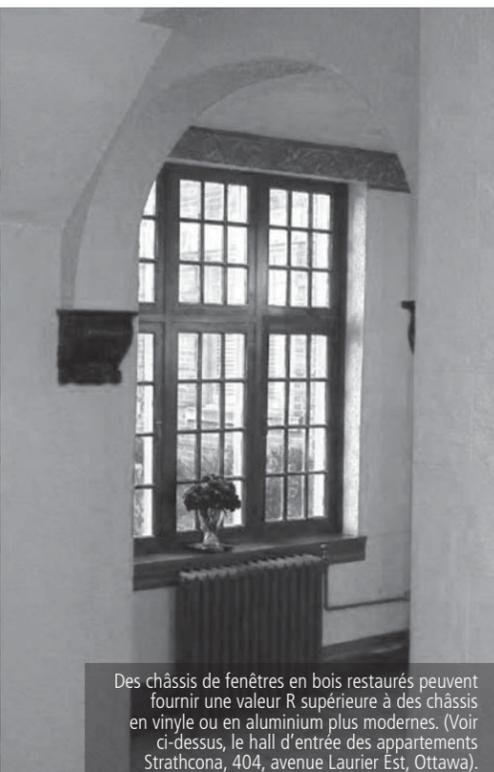
Des châssis de fenêtres en bois restaurés peuvent fournir une valeur R supérieure à des châssis en vinyle ou en aluminium plus modernes. (Voir ci-dessus, le hall d'entrée des appartements Strathcona, 404, avenue Laurier Est, Ottawa.)
